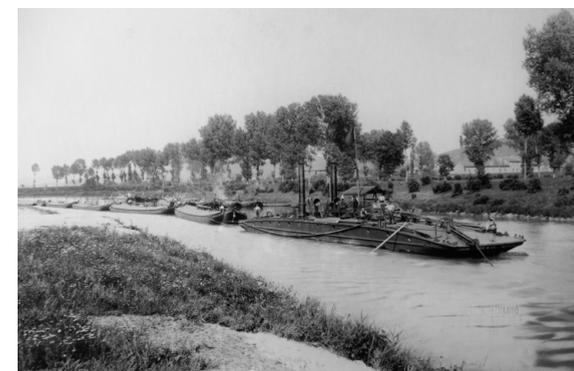
Abb. 16 Kettenschifffahrt auf dem Neckar
